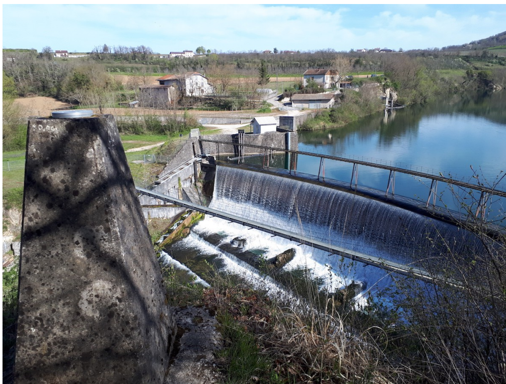
Passerelle sur la Bourne
